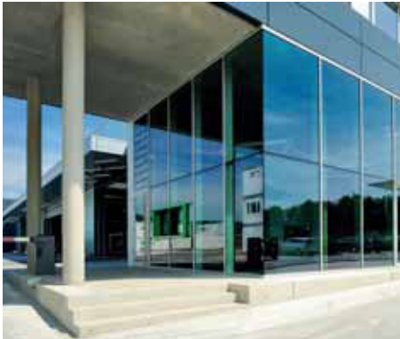
Besonders gelungen ist die Verbindung von Beton- und Modulbauweise. Eine Betondecke überspannt die Durchfahrt und ein als zweigeschossigen Luftraum ausgelegtes, repräsentatives Foyer.
